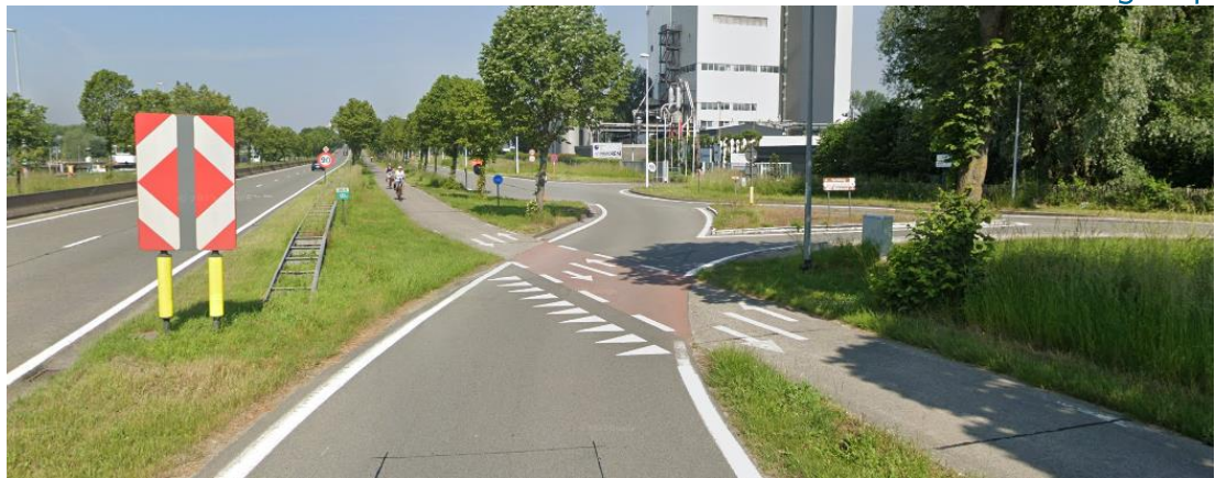
Figuur 19: Kruising F40 met afrit R4 Binnenring (bron: Google Maps)
